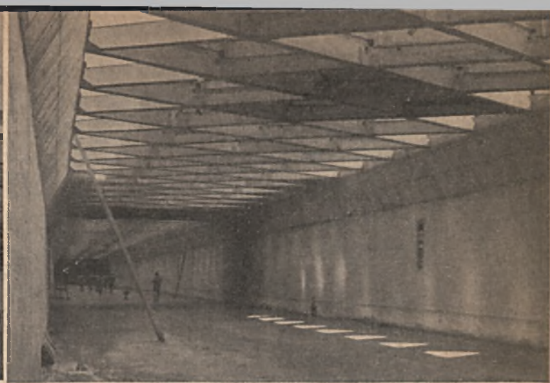
Blick in den teilweise fertigen Autotunnel. Interessant das Gitterwerk für den kontinuierlichen Übergang vom Tages- zum Kunstlicht. Aufn. dds
